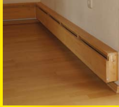
In 20 Minuten warmes Haus dank Heizleistenanlage an den Außenwänden. © sancal
